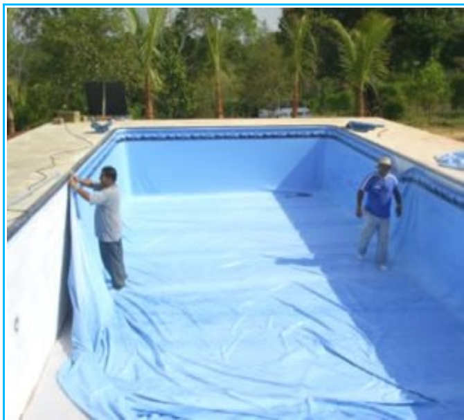
Imagem2- Piscina em construção
