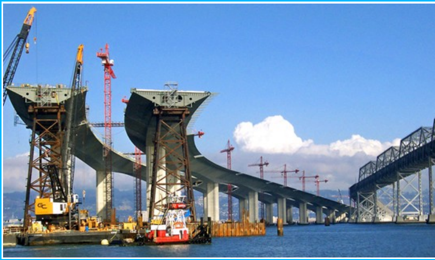
Imagem2- Ponte em construção
